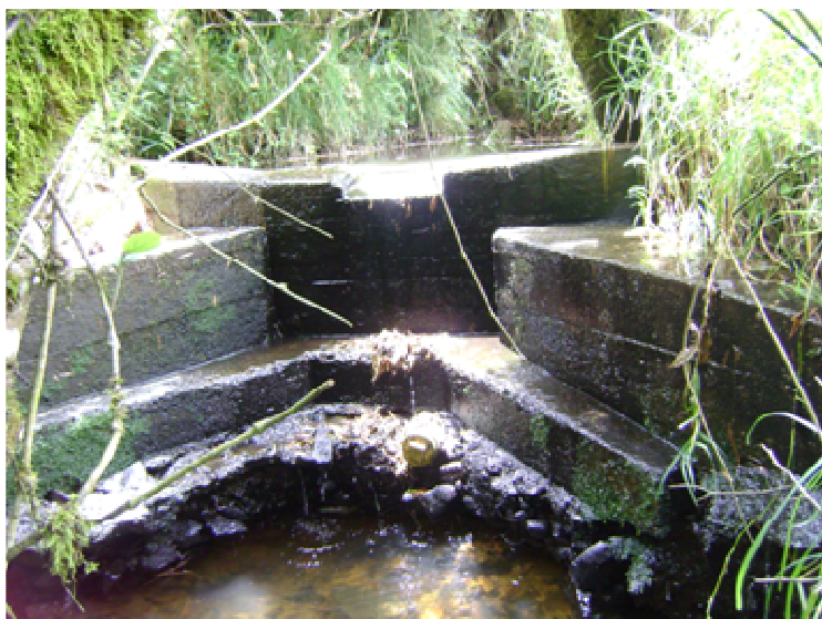
Foto 2. Socavación en la base de la bocatoma de la quebrada San Francisco.
